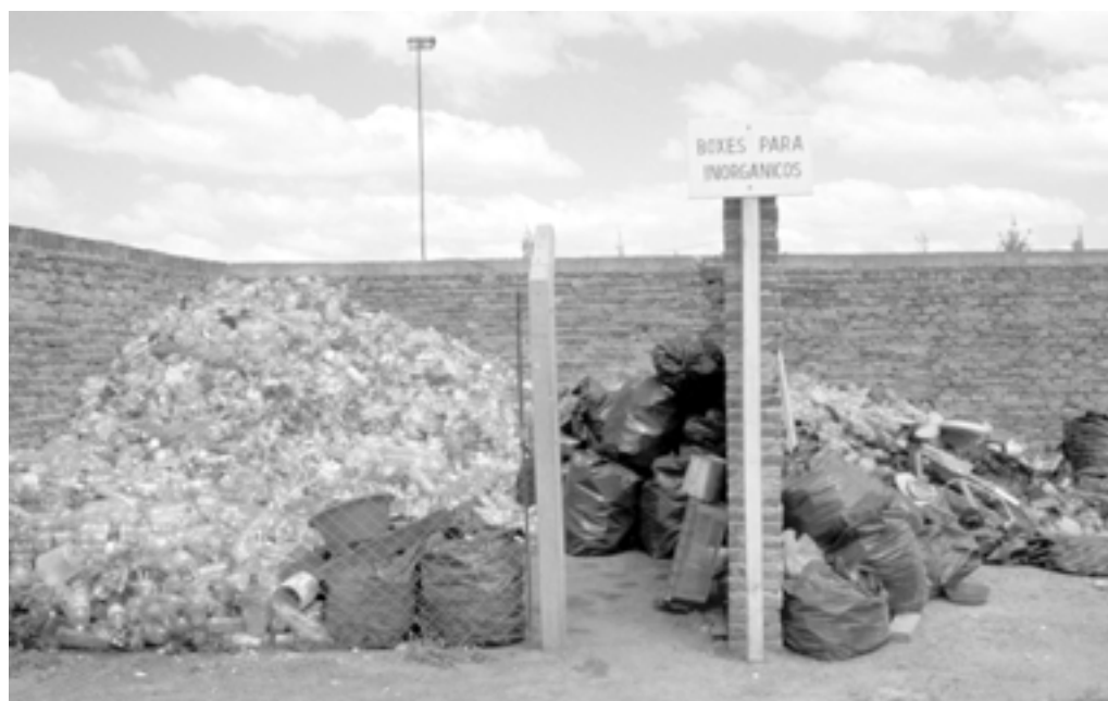
● Planta de reciclado de sólidos urbanos (RSU). Sector de boxes con elementos inorgánicos.
